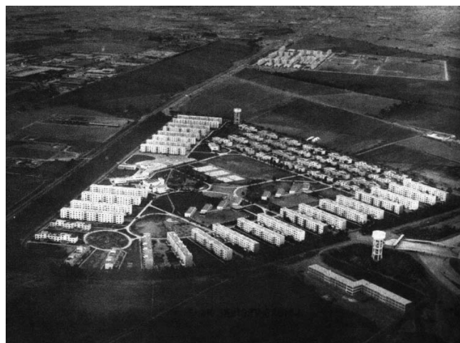
Figura 6. Unidad Vecinal nº 3 (1949). Vista aérea del conjunto. Fuente: Oficina Nacional de Planeamiento y Urbanismo (1958)
